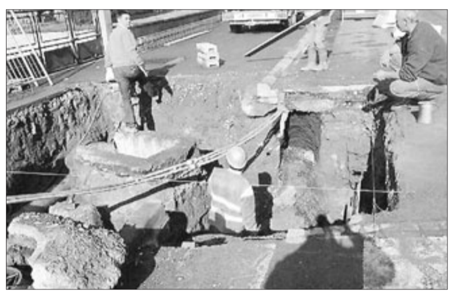
Le bassin d'orage rue de la Forêt était en travaux.
