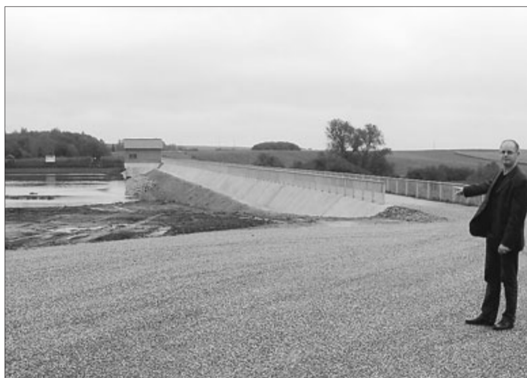
Les travaux à l'étang du Welschoff sont maintenant terminés.
